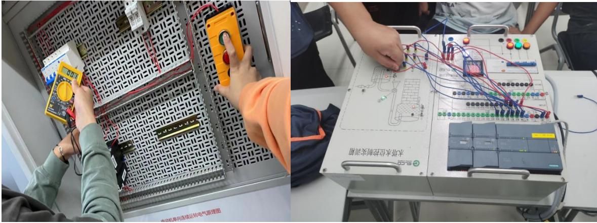
图 13 电器安装和 PLC 实训
